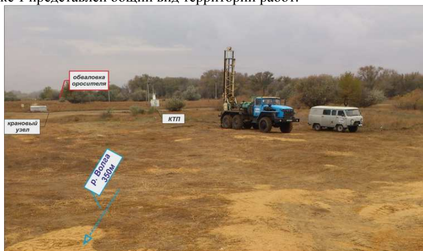
Материалы фотофиксации выполненных работ
